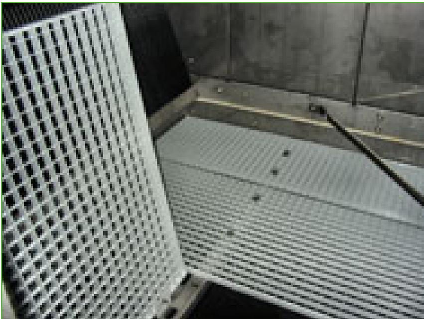
Neben **problemlosem Zugang zur äußeren Oberseite des Geräts** bedeuten die installierte Leiter und Plattform auch einfachere und **sicherere** Inspektion und Wartung in Übereinstimmung mit den **EU-Sicherheitsrichtlinien**.
