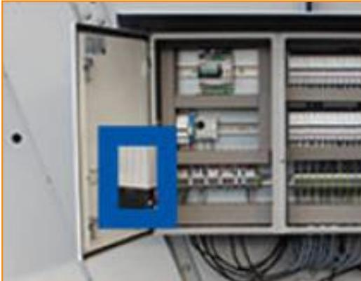
Schützt elektronische Komponenten in der Elektrokonsole während extrem kalten Temperaturen.
