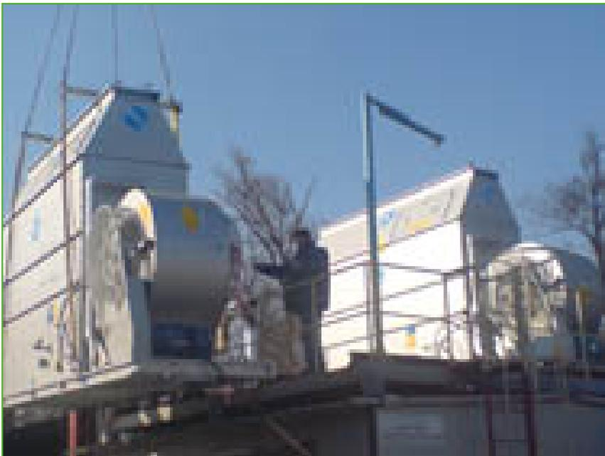
Mit Ausblashauben können Sie Layoutbeschränkungen durch **Erhöhung des** Luftaustritts über angrenzende Wände hinaus und die Steigerung der Ausblasluftgeschwindigkeit zur **Verringerung des Risikos der Rezirkulation** bei engen Aufstellungsverhältnissen erfüllen.
