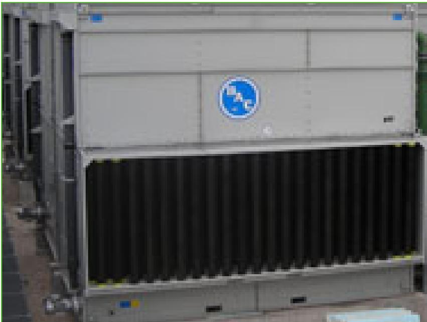
HXI Hybrid-Kühltürme mit geschlossenem Kreislauf verwenden **leise und leistungsarme Axiallüfter**, um aber die Geräusentwicklung noch weiter zu verringern, können Sie Ihren HXI-Kühlturm durch [Schalldämpfung](#) erweitern: zylindrische Kulissen am Lufteintritt.
