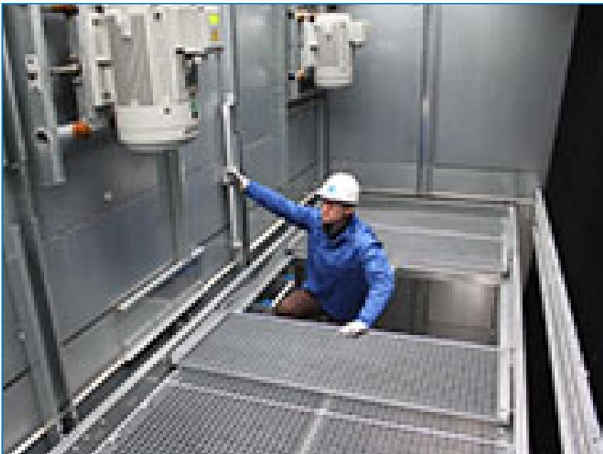
Neben **problemlosem Zugang zur äußeren Oberseite des Geräts** bedeutet die installierte innere Plattform auch einfachere und **sicherere** Inspektion und Wartung in Übereinstimmung mit den **EU-Sicherheitsrichtlinien**.
