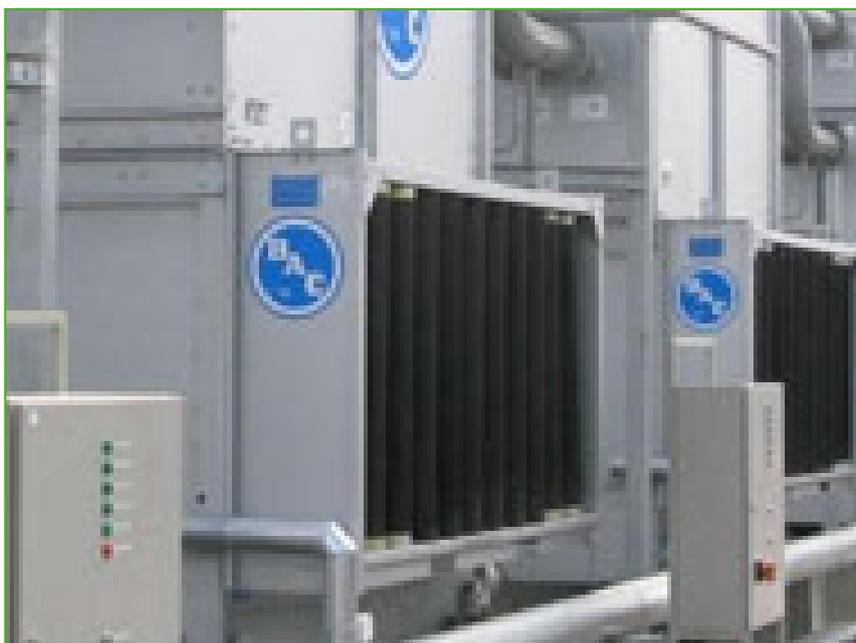
Le torri di raffreddamento a circuito chiuso FXVS montano **ventilatori assiali silenziosi e a basso consumo energetico** ma, per ridurre ulteriormente la rumorosità, possono essere integrate mediante un dispositivo di attenuazione acustica:
