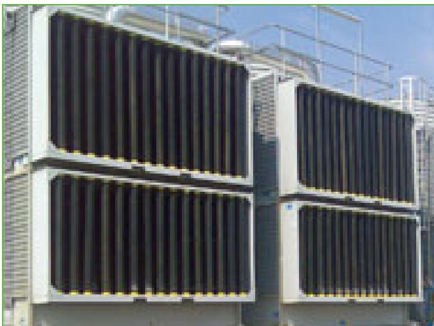
Le torri di raffreddamento a circuito chiuso FXVT montano **ventilatori assiali silenziosi e a basso consumo energetico** ma, per ridurre ulteriormente la rumorosità, possono essere integrati mediante un dispositivo di attenuazione acustica:
