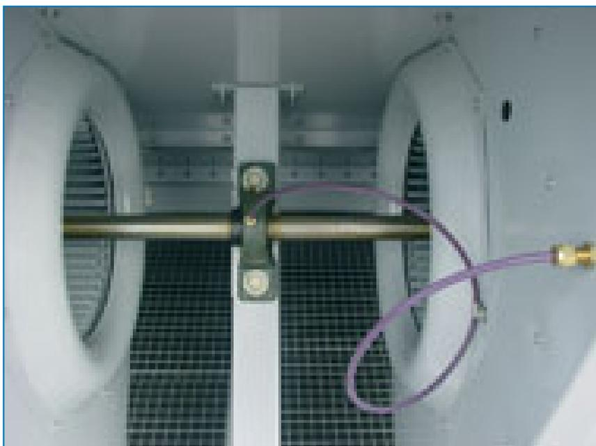
Для смазки подшипников вала вентилятора могут быть использованы удлиненные смазочные линии со смазочными фитингами. Фитинги расположены внутри пленума рядом с дверцей люка.
