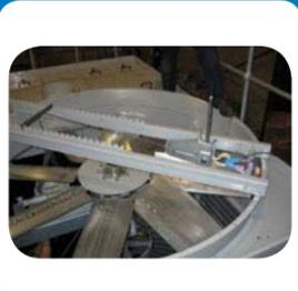
Sistema di rimozione delle apparecchiature meccaniche
