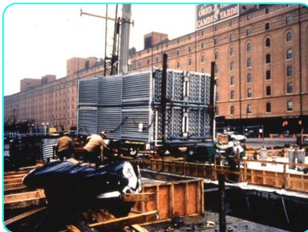
Im Betontank installierte Rohrbündel
