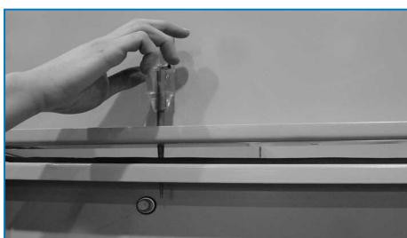
Использование штифта для выравнивания резьбовых отверстий
