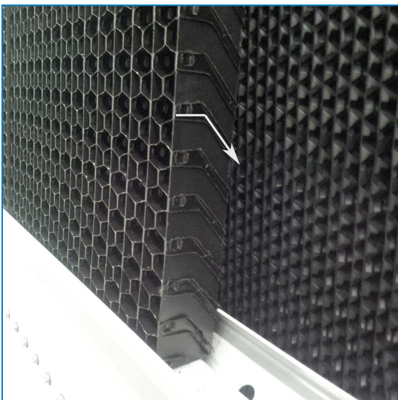
Ориентация комбинированных экранов на входе
