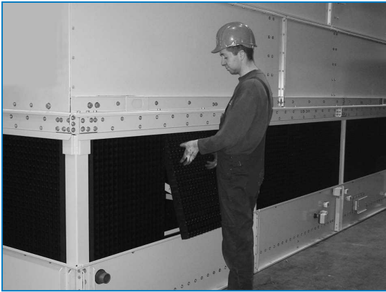
Снятие комбинированных щитов на входе
