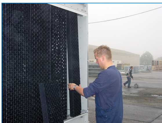
Снятие комбинированных щитов на входе
