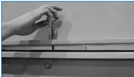
Verwendung des Treibdorns zur Ausrichtung der Schraublöcher
