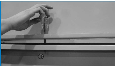
Verwendung des Treibdorns zur Ausrichtung der Schraublöcher
