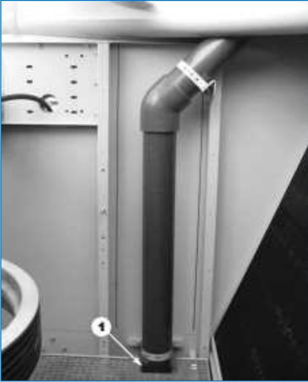
*Interior de la sección de plenum de la tubería de la bomba*
