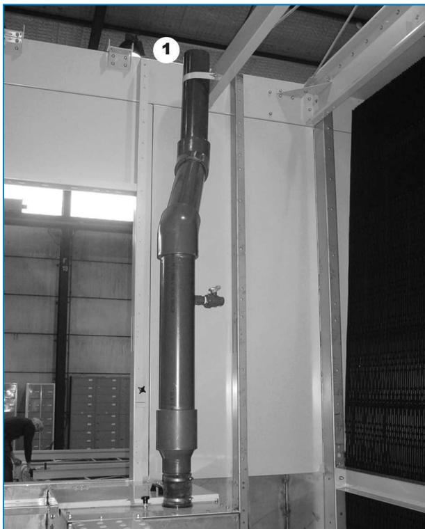
*Sección inferior de la tubería de la bomba*
