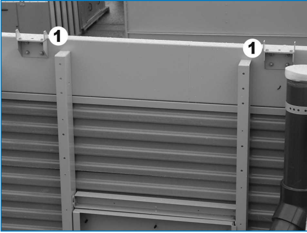
Vista interior de la sección inferior
