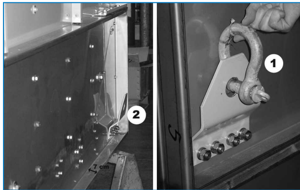
Instalación de varias celdas
