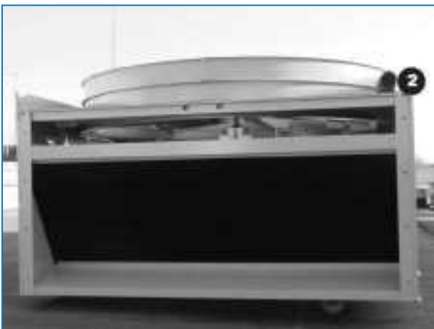
Exterior de la conexión de tubería de la bomba en sección de plenum
