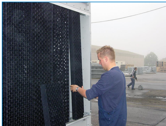
Retire los filtros de acción múltiple
