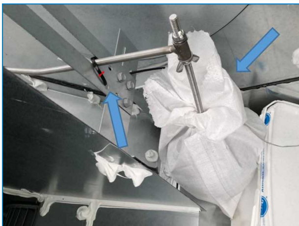
Fissaggio e avvolgimento della palla galleggiante
