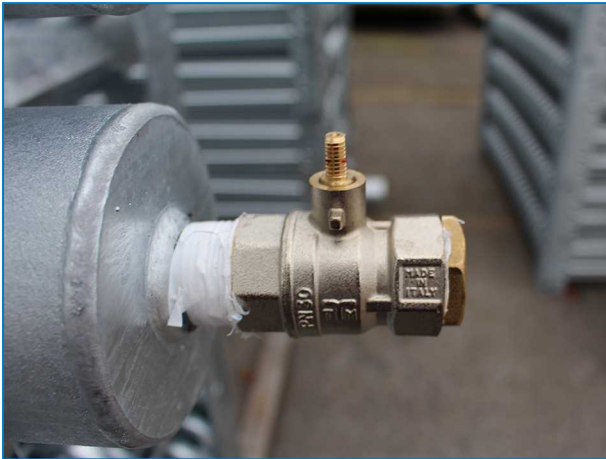
Attacco batteria superiore con valvola limitatrice di pressione sui condensatori.
