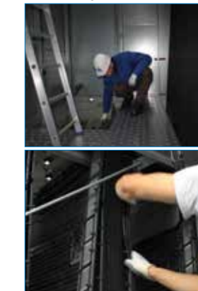
Patentierter BACross Füllkörper für Lamelle nach Lamelle Inspektion und Reinigung
