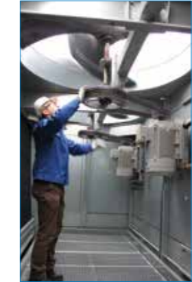
Lüfterantrieb leicht zugänglich beim Stehen
