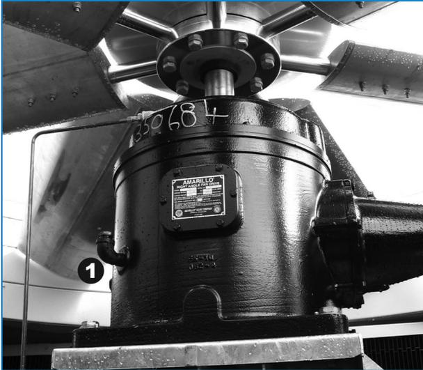
Getriebe mit einfacher Übersetzung
