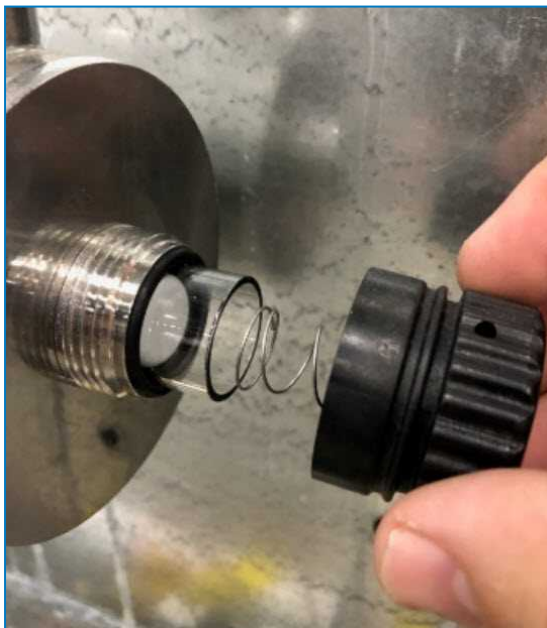
Entfernen des UV-Quarzhüllrohrs
