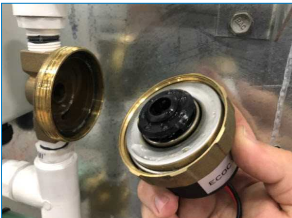
Pumpenkörper und Spiralgehäuse
