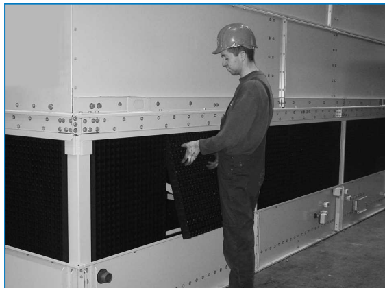
Kombinierte Lufteintrittsschutzelemente entfernen
